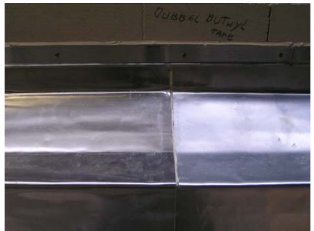
..... of dubbelzijdig butyl tape. Overlap van 10 cm aanhouden.
