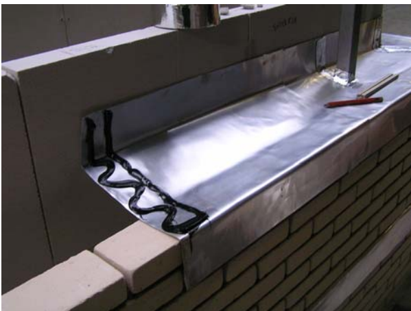
Verbindingen. Flexibele kit op de rand van de strook aanbrengen.....
