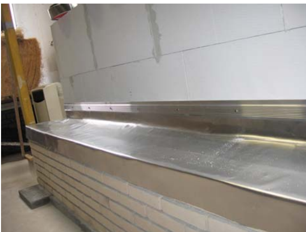
Fixeren aan ondergrond. Vastzetten met een RVS knelstrip .....
