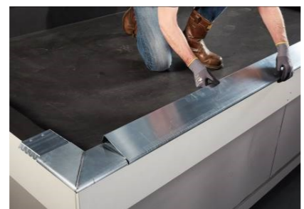
5. Haak de kraal om de klang en klik deze aan de achterzijde vast.
