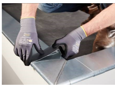
6. Werk de overgang af met het koppelstuk.
